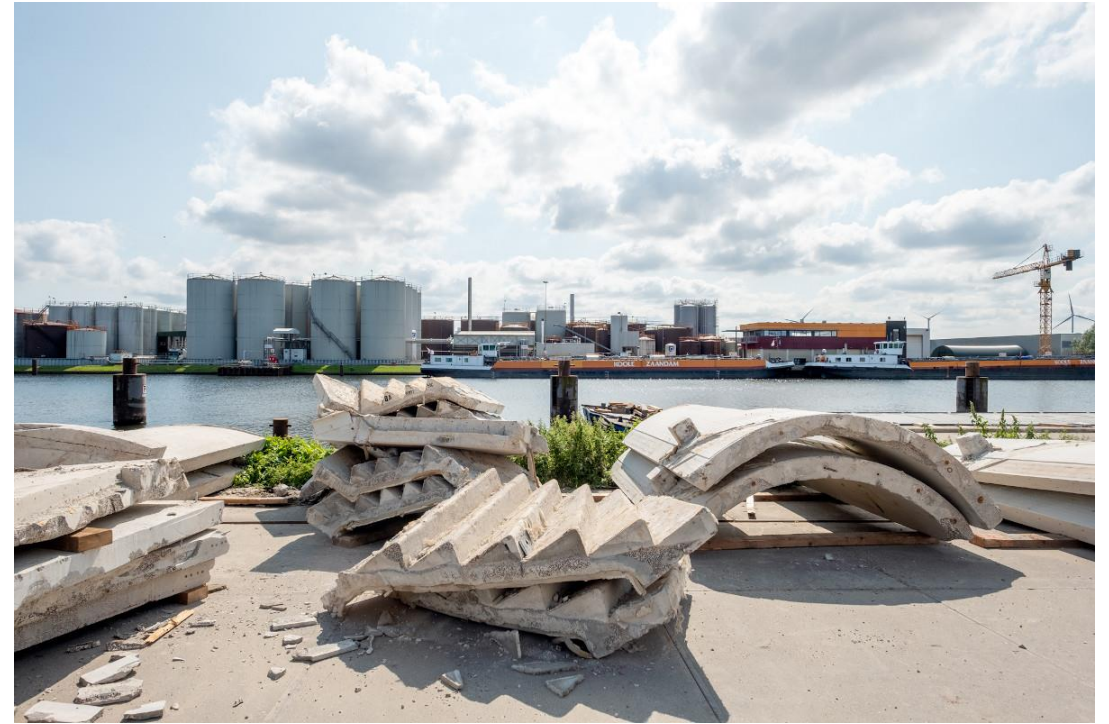
Geogste betonnen trappen
