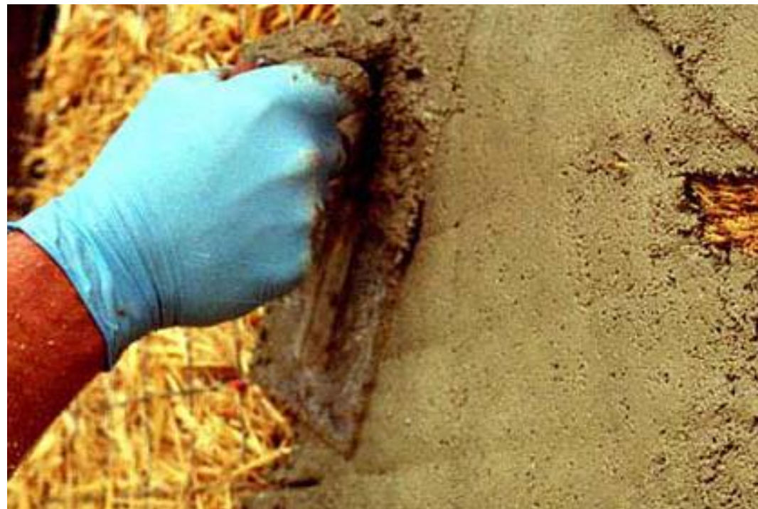
Stro-bouw met leem afwerking
